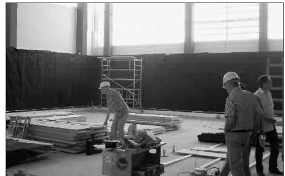
Mittelschule Lichtenau Innenausbau der neuen Sporthalle.
