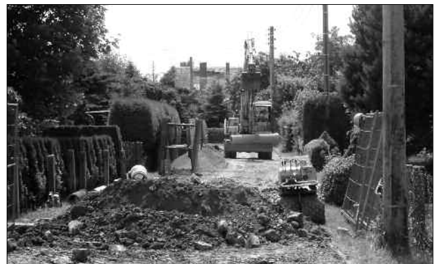
Ausbau Obere Siedlung, 8. BA Tiefbauarbeiten an der Karl-Hartig- Straße.
